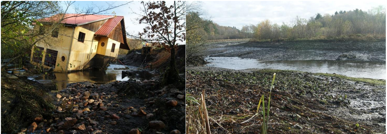
Figur 1: Brande Elværk, dagen efter digebruddet (t.v.). Skjern Å's forløb på den tørlagte søbund (t.h.).
