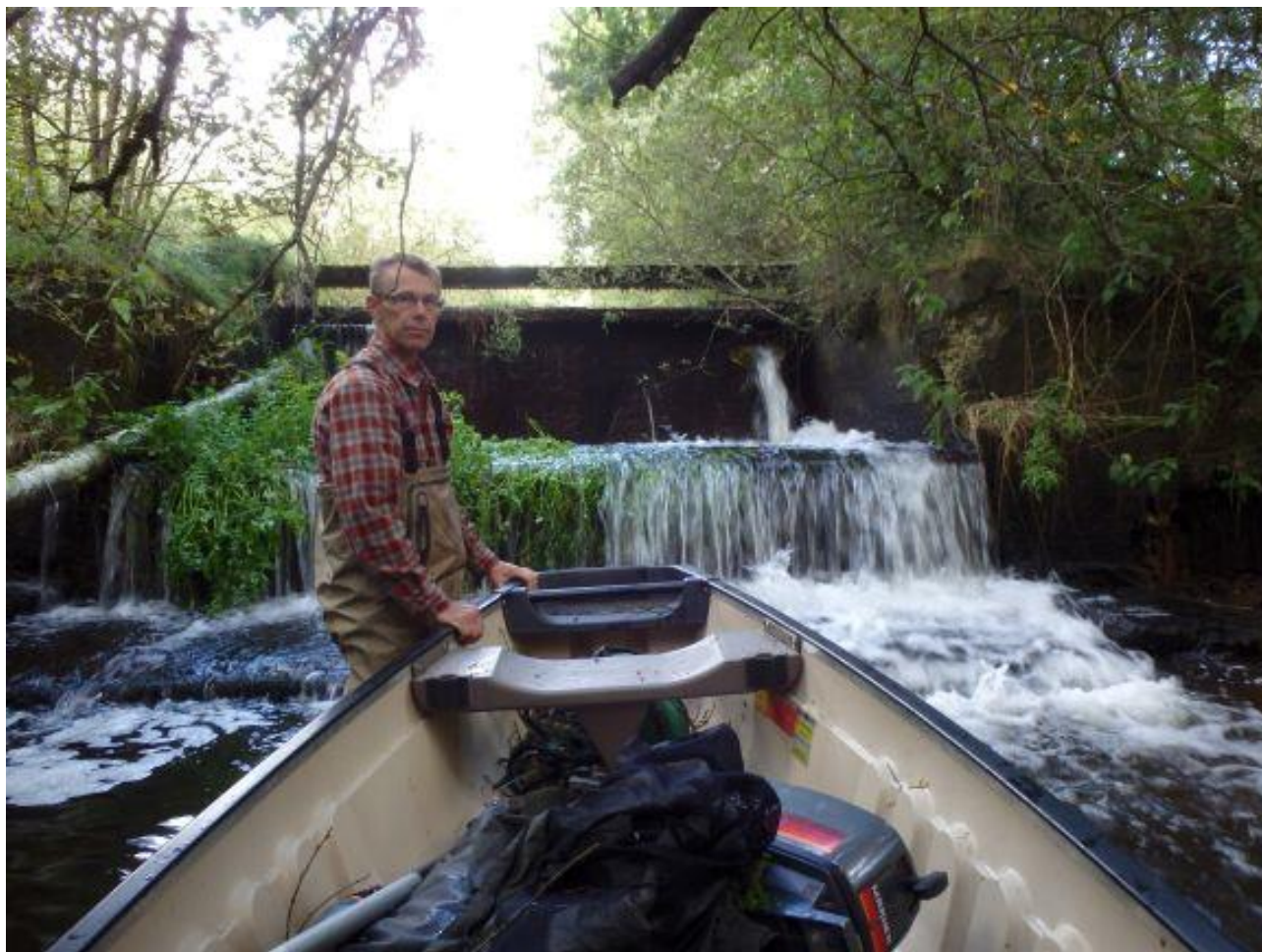
Figur 2: Stemmeværk ved vandindtaget til Østerbygård Dambrug. Stemmeværket er ikke passabelt for laks.
